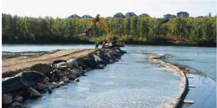
Fig. 2.12. Silt curtain
