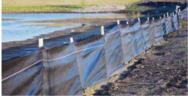
Fig. 2.13. Silt fence
